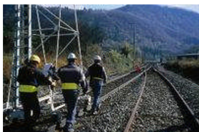
Entre Thonon-les-Bains et Annemasse (74). Travaux sur le réseau ferroviaire.
