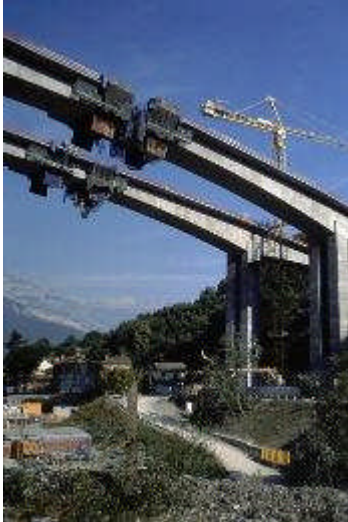
Construction d'un viaduc sur l'autoroute A51.
